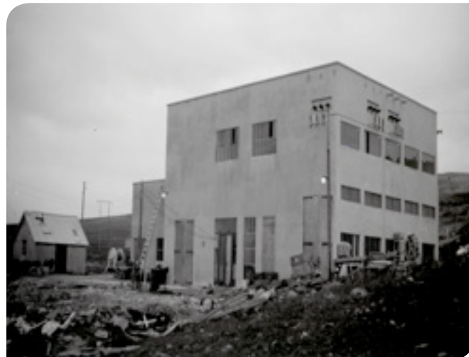
Fra byggingen av Kongsfjord kraftstasjon.
