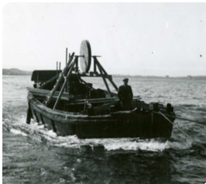
Sjøkabel legges i Bussesundet. Dette bildet kan være fra 1946, da det ble lagt ny kabel etter at den forrige ble ødelagt av en mine.
