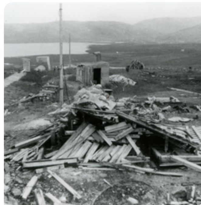
Under anleggsperioden da Kongsfjord kraftstasjon ble bygd på slutten av 1930-tallet.
